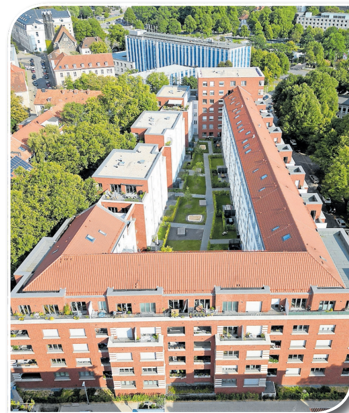
Großprojekt an der Adolfstraße in Hannover.
